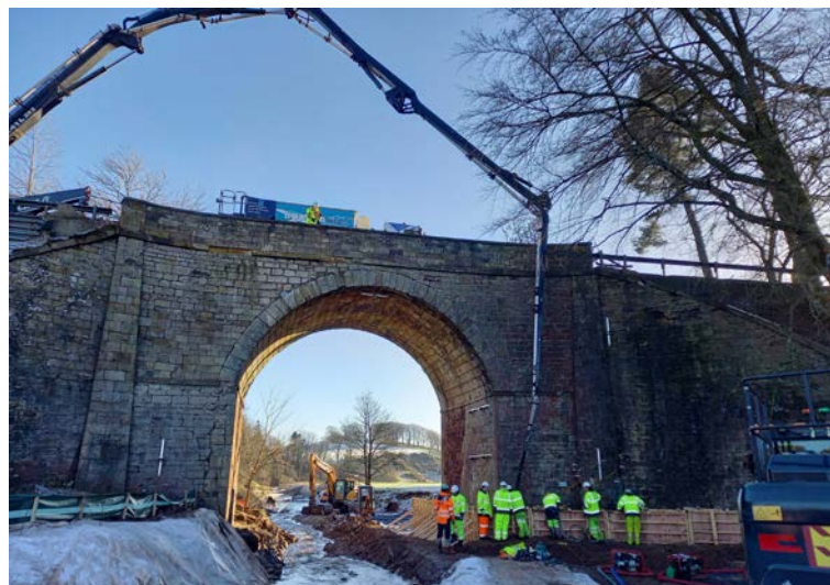
Figure 12 A702 80 Westwater concrete pour
